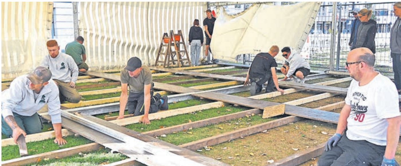
Beim Freundeskreis Buchenhof sorgten viele Helfer für die Stabilität des Festzeltes und die Verlegung eines Holzbodens.
