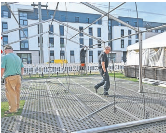
Beim Angelsportverein wurden Kunststoff-Klickfliesen als Unterlage verlegt.
