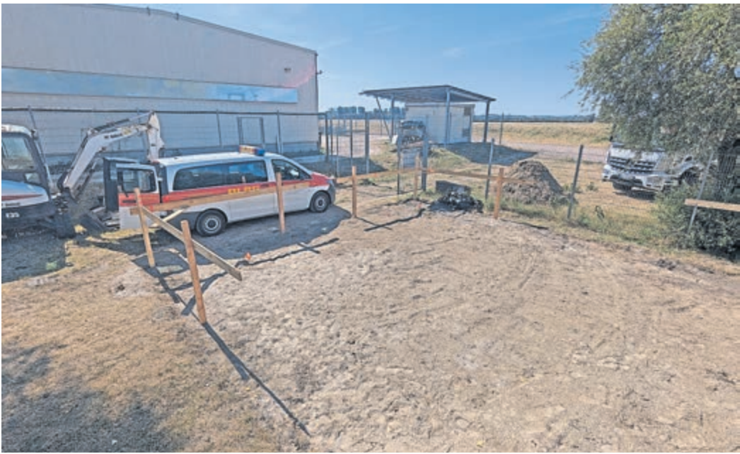
Für die kommende Wachstation der DLRG Pfungstadt am Eicher See wird derzeit das Fundament vorbereitet, ehe im Herbst die Container gestellt werden sollen. Foto: DLRG
