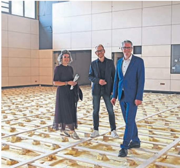
Landrat Christian Engelhardt (rechts) erklärte bei einem Besuch auf der Baustelle der Marie-Curie-Schule in Lorsch, dass die Gebäude zum zweiten Schulhalbjahr von der Schülerschaft bezogen werden könnten. Foto: Burmeister
