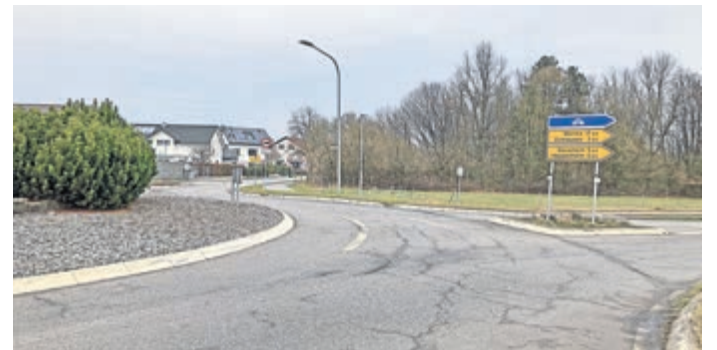
Die Fahrbahn am Kreisverkehrsplatz Starkenburgring/Friedensstraße in Lorsch wird erneuert. Foto: Hessen Mobil
