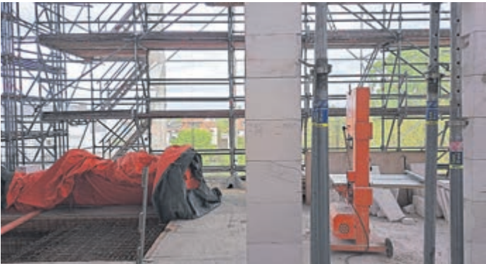
Einen guten Ausblick hat man aktuell aus dem Rathaus in Griesheim, denn noch werden hier umfangreiche Sanierungsarbeiten durchgeführt. Foto: Stadt Griesheim
