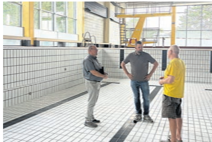
Bürgermeister Niklas Gehnich (Mitte) erkundigt sich vor Ort über den Fortschritt der Reinigungs- und Instandsetzungsarbeiten. Foto: Stadt Weiterstadt
