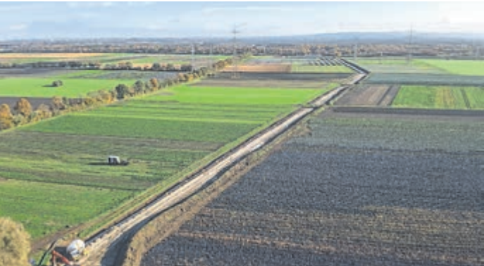
Die „Neue Riedleitung“, die derzeit gebaut wird, soll dazu beitragen, die regionale Wasserversorgung langfristig an den Klimawandel, veränderte Verbrauchsmuster und den steigenden Spitzenbedarf anzupassen.
