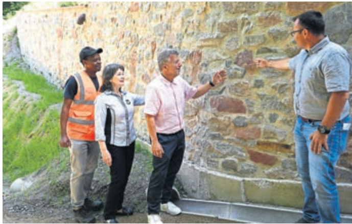
Die Sanierung der historischen Stützmauer in Schönberg ist nun abgeschlossen. Von links: Jean de Dieu Ntamugabumwe, Projektleiter beim KMB, Ulrike Klöble, Ortsvorsteherin Schönberg, Frank Daum, Erster Stadtrat der Stadt Bensheim und Verbandsvorsitzender des KMB und Lars Stuckert, Technischer Geschäftsführer.
