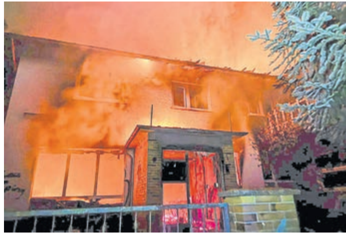
Die Einsatzkräfte der Feuerwehr fanden das Storckebrünchen bei ihrem Eintreffen bereits komplett in Flammen vor, der Dachstuhl war in Teilen eingestürzt, ein Innenangriff aus Sicherheitsgründen nicht mehr möglich. Foto: Feuerwehr Stadt Weiterstadt
