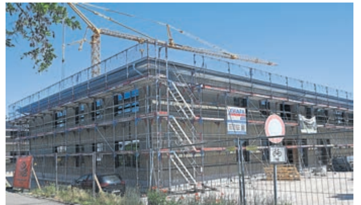
Die Marie-Curie-Grundschule wird in Modulbauweise errichtet. Foto: Burmeister
