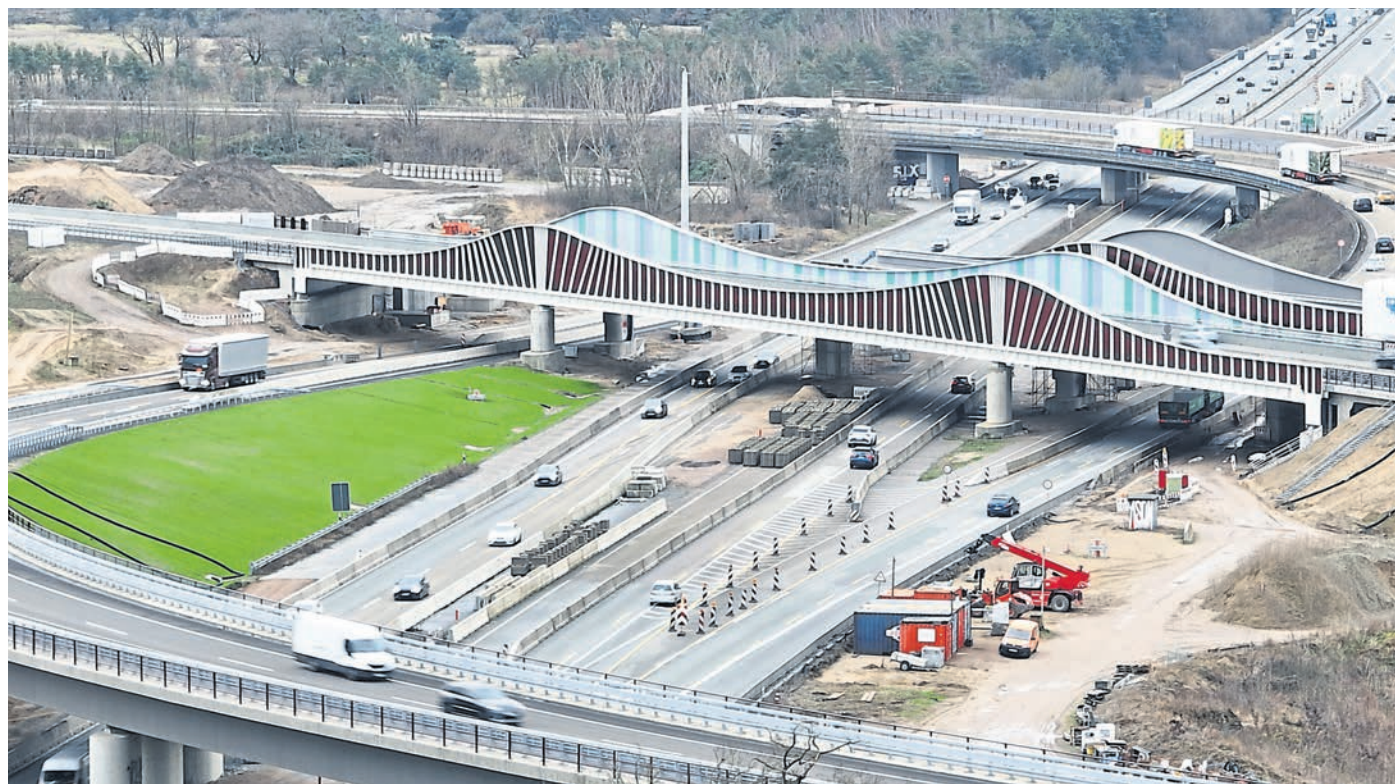
Das Zentralbauwerk am Darmstädter Kreuz wird in den kommenden Wochen verschoben. Das hat auch Auswirkungen auf den Verkehr. Foto: Autobahn GmbH/Kaluscha
