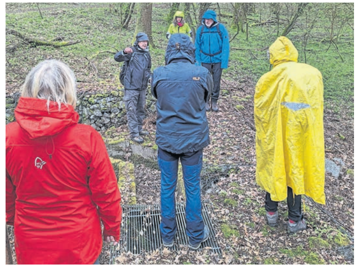
Gerald Hoffmann zeigt an dieser Stelle den alten Überlauf aus dem Regenrückhaltebecken des Seeheimer Elsbachs. An dieser Stelle soll auch die neue Zuwässerung ab Dezember in die alte noch vorhandene Rohrleitung erfolgen. Foto: Verein
