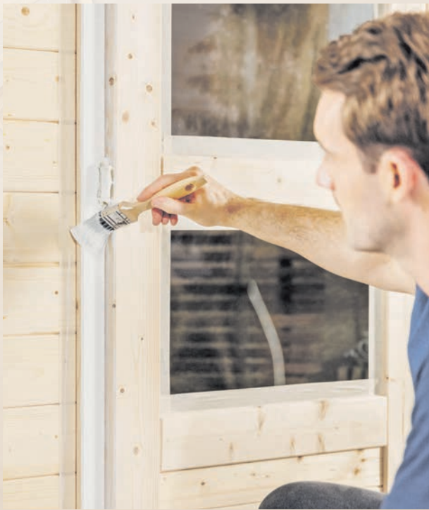
Wetterschutzfarbe gibt es in Weiß oder bunten Farben. Eine Grundierung ist gerade bei hellen Tönen ratsam. Foto: djd
