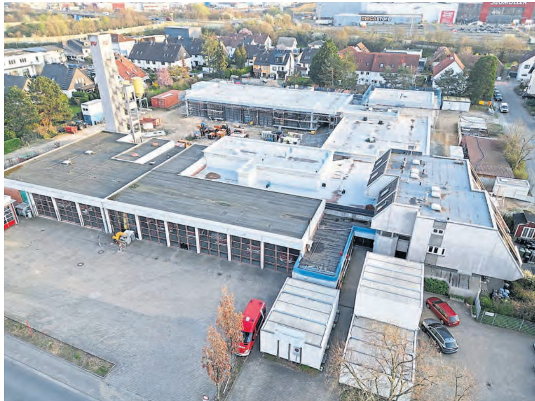
Aktuell sieht es bei der Feuerwehr in der Rudolf-Diesel-Straße in Weiterstadt immer noch nicht so aus, als würden die Arbeiten zeitnah fertiggestellt werden können. Der Umbau schränkt die ehrenamtliche Arbeit aller Feuerwehrabteilungen seit Jahren ein und stößt bei den Feuerwehrleuten mittlerweile auf Unverständnis. Foto: Feuerwehr der Stadt Weiterstadt
