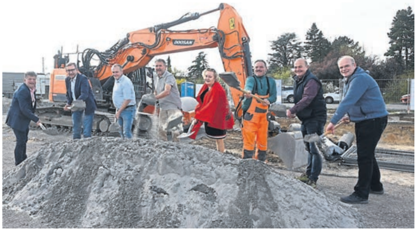
Am vergangenen Donnerstag fiel der Startschuss für die Errichtung des neuen Bauhofs.
