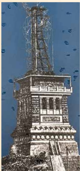
Die Tafel am Sockel der Freiheitsstatue zeigt auch die Stahl-Unterkonstruktion von Gustave Eiffel. wb-foto
