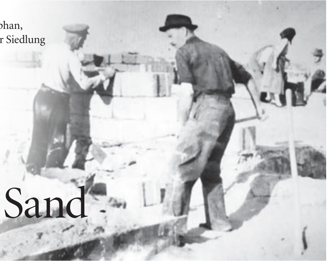
Alle Siedler packten fleißig mit an, um die neuen Häuser fertigzustellen.
