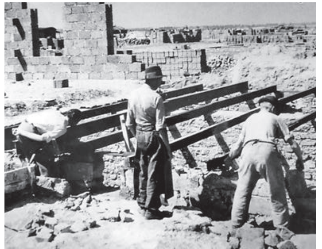
Im Juli 1948 konnte der Bau in der Donau- und Draustraße beginnen. In der Donaustraße waren elf, in der Draustraße acht Doppelhäuser vorgesehen.
