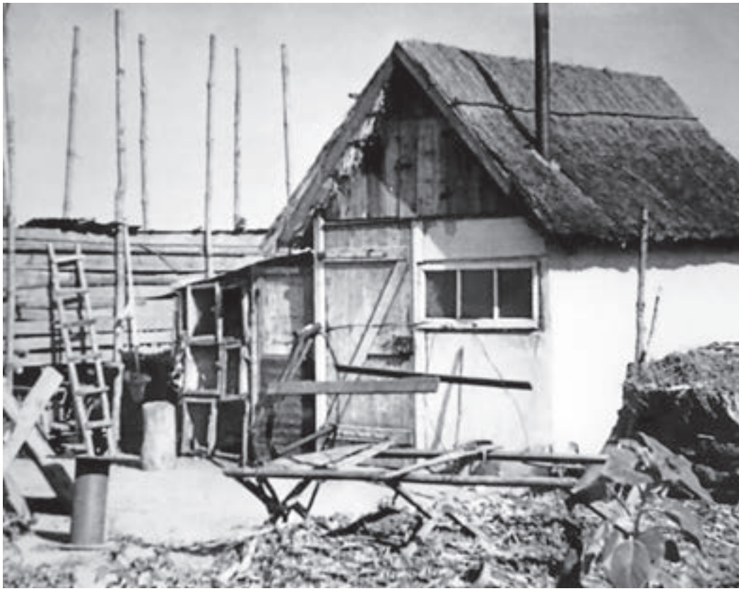
Die Baracken wurden im rheinland-pfälzischen Ziegenhain zerlegt und mit dem Zug nach Darmstadt transportiert. Mit mehreren Fuhren wurden sie dann nach St. Stephan gebracht.
