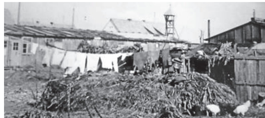
Bevor das Bauvorhaben starten konnte, mussten die Siedler in Notunterkünften wohnen.
