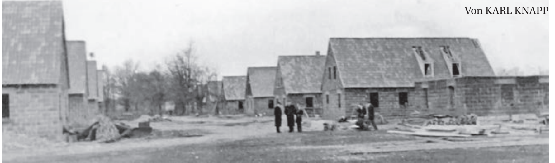
Die Häuser der neuen Siedlung St. Stephan im Rohbau.
